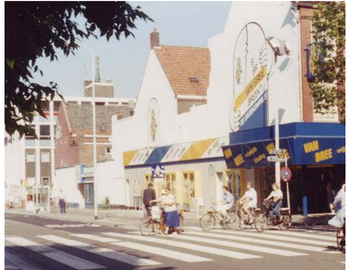
Gesloopte bebouwing tbv huidige Catharinahuis 1995
