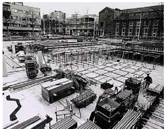
Aanleg parkeergarage op het Stadhuisplein 1996
