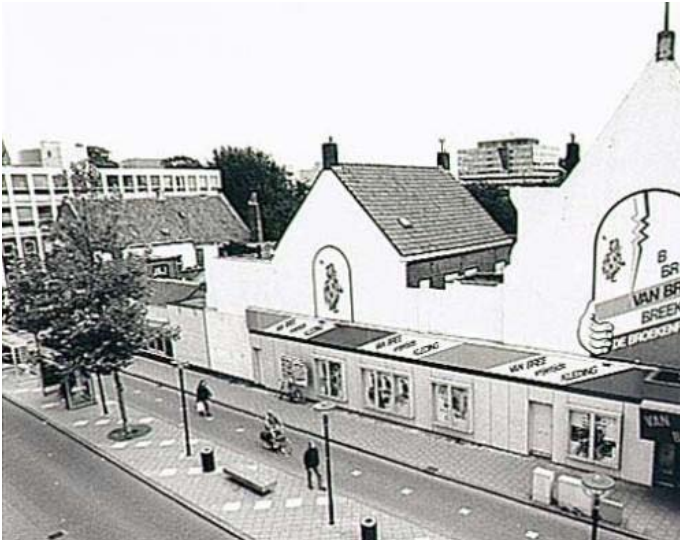
Gesloopte bebouwing tbv huidige Catharinahuis 1995
